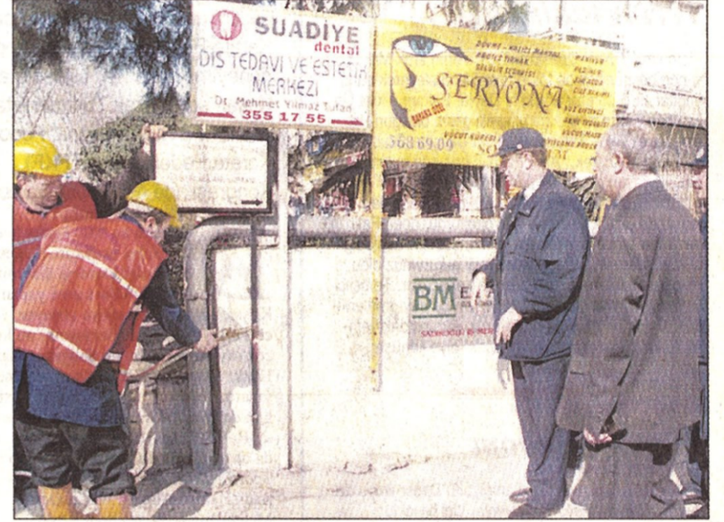
Ruhsatsız olduğu belirlenen tabelalar, oksijen kaynağı ile kesilerek söküldü. Çalışmalar önümüzdeki günlerde de devam edecek.
